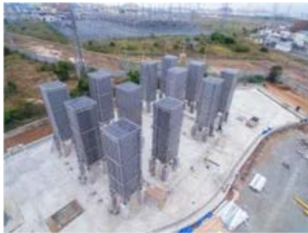
Photo 5: Example of an LNG Ambient Air Vaporizer
